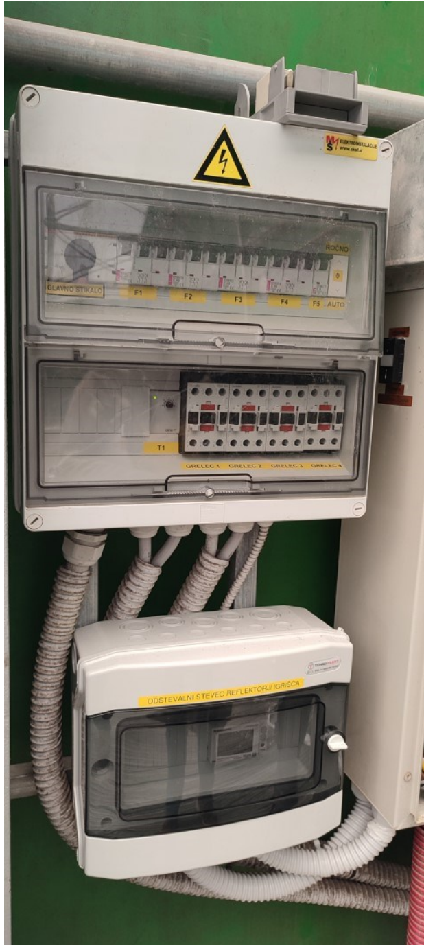
Fotografija 7: odštevalni števec, poleg glavne razdelilne omare balinišča
