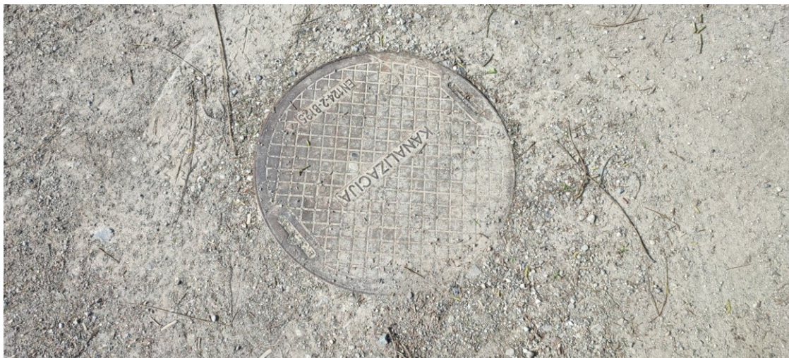
Fotografija 11: priključni kanalizacijski jašek javne kanalizacije, severno od objekta ŠRC.
