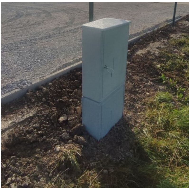
Fotografija 3: zunanja el. omarica za napajanje el. energije razsvetljave srednjega igrišča
