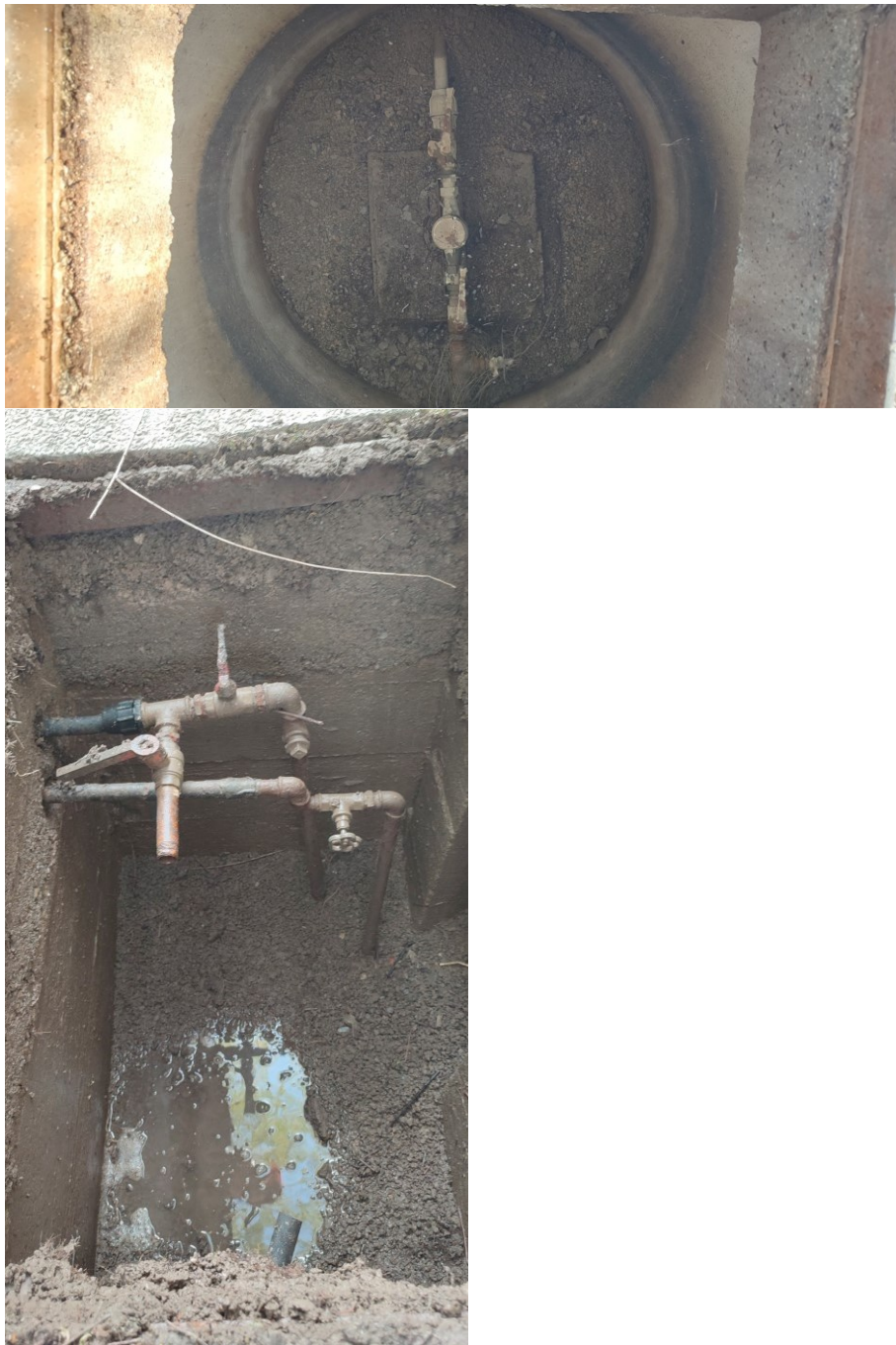
Fotografija 10: vodomernega jaška in hišnega priključnega jaška internega vodovoda.
